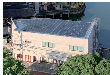
本社移転に伴い、1978年2月竣工された既築建築物(鉄骨造)の改修工事を行い、ZEBを達成。客観的な評価を受けるべく、BELS評価を利用し、省エネ性能を担保しています。高断熱性能と高効率設備の導入により、一次エネルギー消費量の基準値57%削減(BEI:0.43)。さらに、約45kWの大容量太陽光発電システムを搭載し、117%削減(BEI:-0.17)を実現しました(※)。併せて、使用電力(オール電化)は再生可能エネルギーを利用。社用車のEV化を視野にEVコンセントも設置しています。
